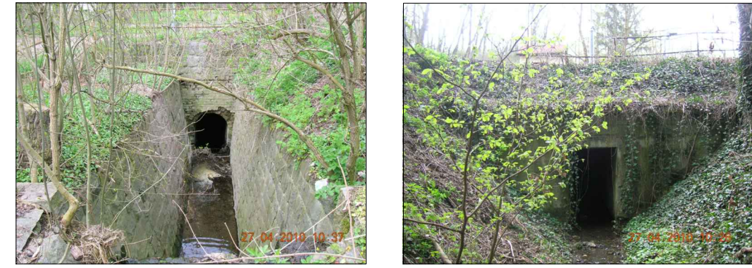
ZAKLENUTÍ, d. 107 m PO2 - km 0,111 Q5 = 00,44 m3/s Q20 = 00,68 m3/s Q100 = 01,06 m3/s
